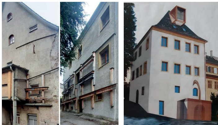
Das statisch gesicherte Gebäude heute. Fotos: Domus Judaeorum e.V. Visualisierung des von Architekt Werner Tscholl revitalisierten Gebäudes ab 2027
