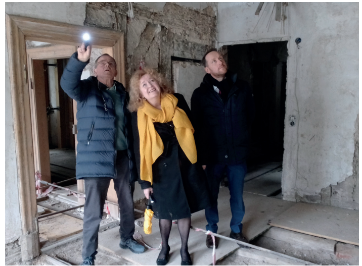
Prof. Barbara Traub wird von Robert Dinser (l.) und Erstem Bürgermeister Christian Baron durch das stark sanierungsbedürftige Gebäude geführt.
